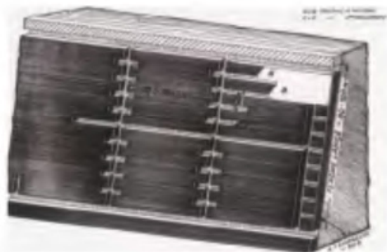
Fot. 26. Roboty udostępniające
