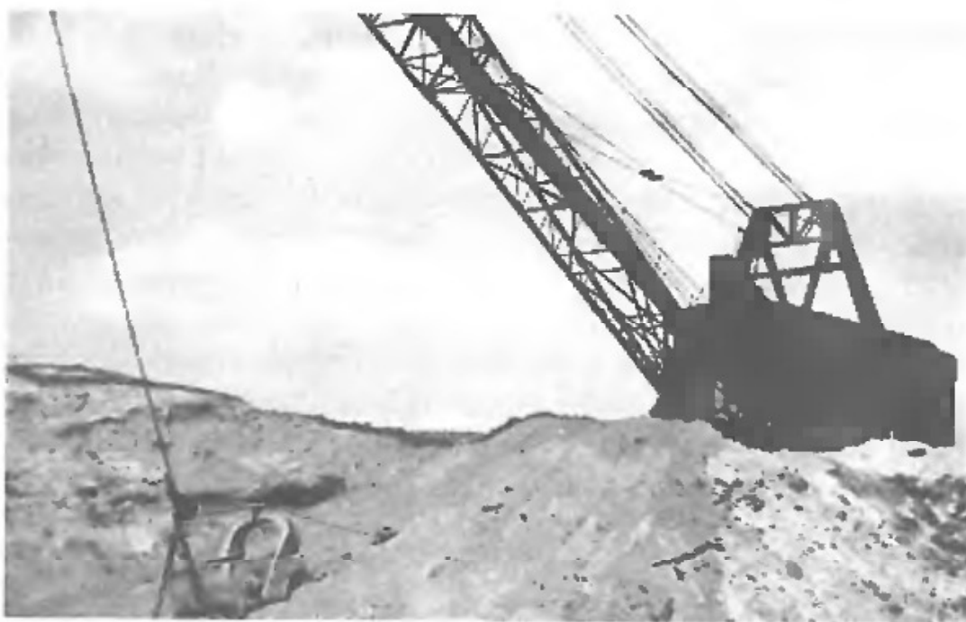
Zgarniarka linowa na KPP Dzieńkowice
