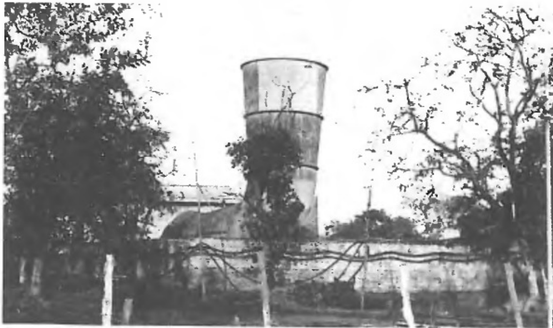
Kop. Sudamdih Upadowa – wentylator główny
