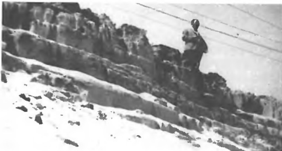
KPP Dzieckowice – skarpa wykopu
