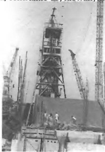
Kop. Moonidih – szyb I w budowie
