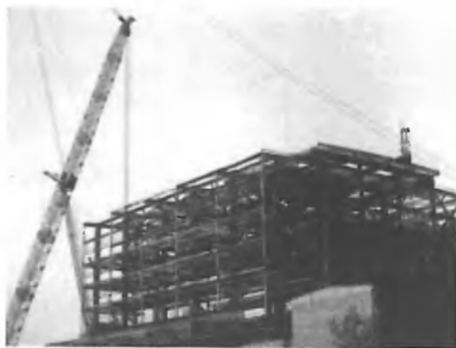
Kopalnia Jankowice – budowa brykietowni
