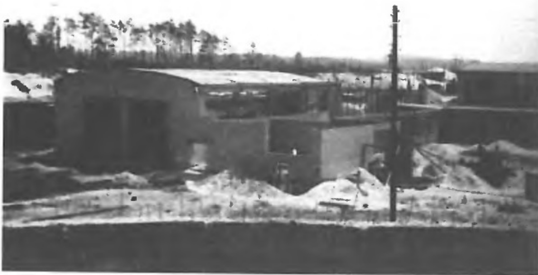
KPP Dzieckowice – budowa lokomotywni
