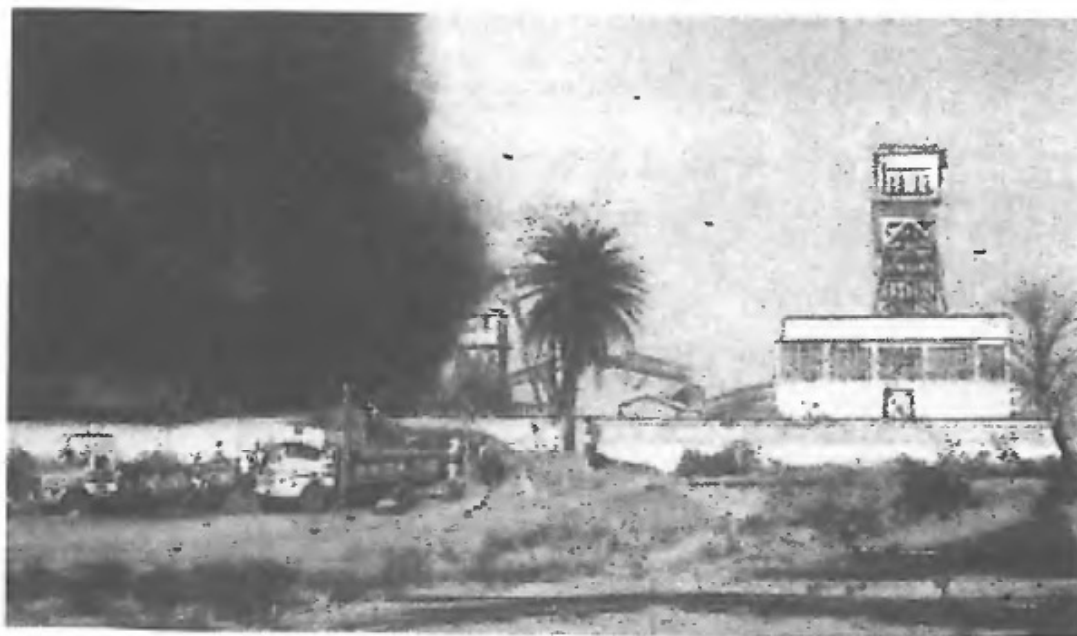
Dymy pożarowe wydobywające się z dyfuzora wentylatora na kop. Sudamdih
