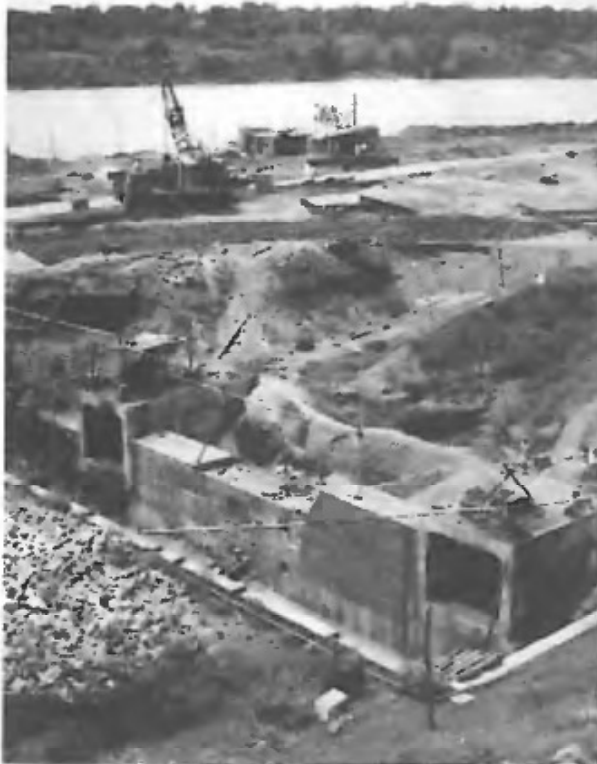
Kop. Sudamdih – budowa budynku zmywczego
