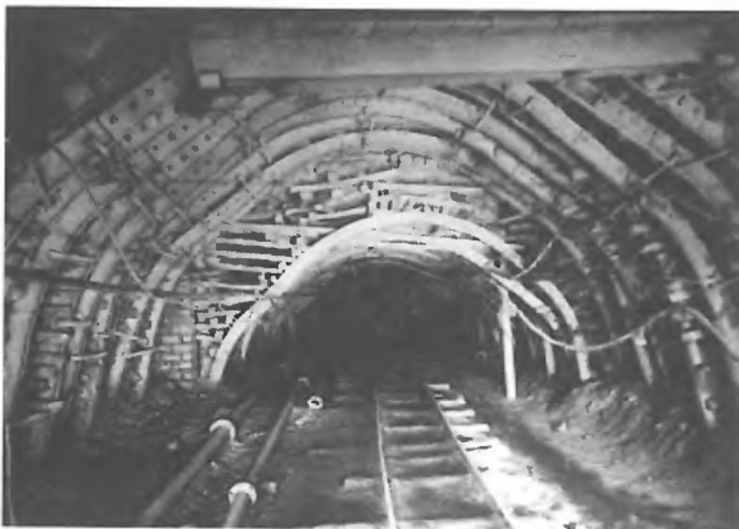
Kop. Jitpur – obudowa upadowej
